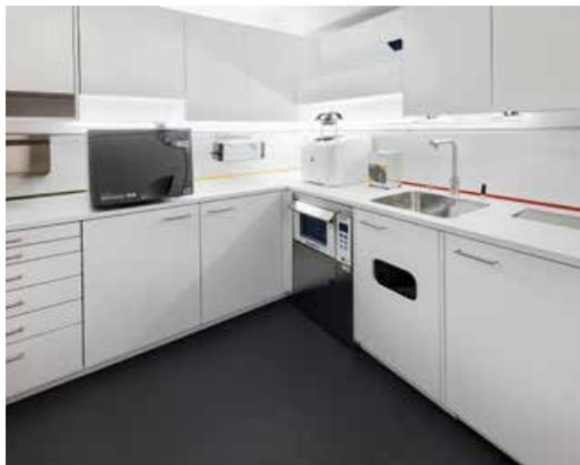
**Alles ist am richtigen Platz:** Der Sterilisationsraum ist funktional und auf dem neusten Stand. Wegen der tiefen Deckenhöhe ist die Klimatisierung in die Möblierung integriert. Die indirekte Beleuchtung der Decke lässt den Raum höher wirken.
